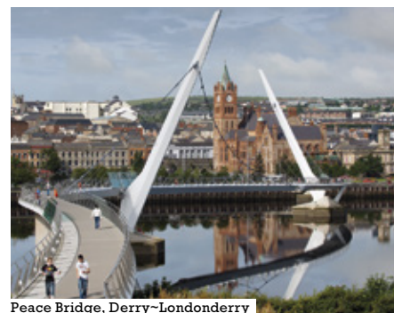
Peace Bridge, Derry~Londonderry
